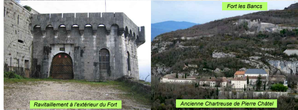
L'accès au Fort
